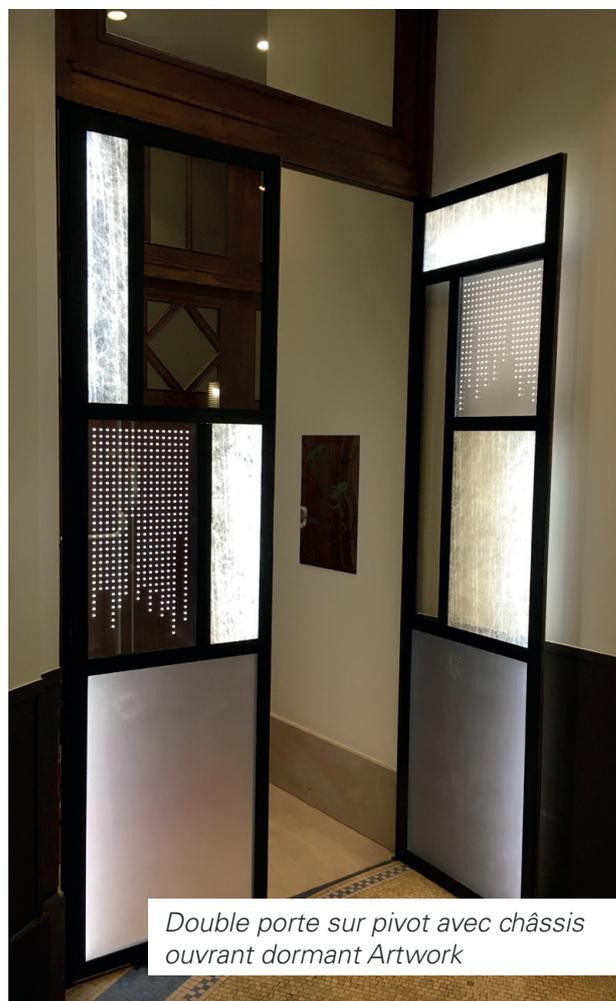
*Double porte sur pivot avec châssis ouvrant dormant Artwork*
