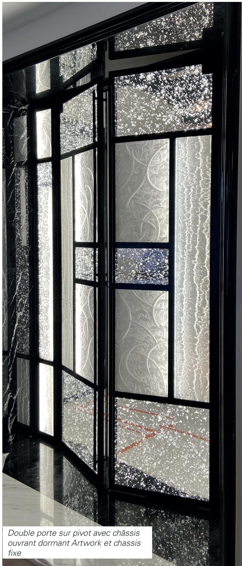
*Double porte sur pivot avec châssis ouvrant dormant Artwork et châssis fixe*
